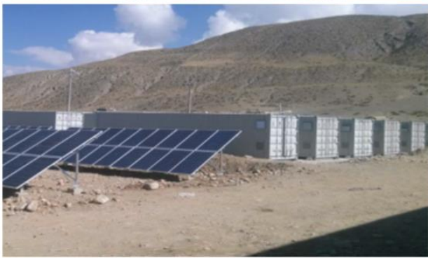
PHOTO 1: INSTALLATION TYPIQUE DE BESS
