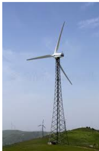
FIGURE 11 : NOUVELLE CONCEPTION (EN TREILLIS METALLIQUE)
