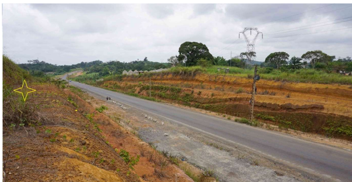
Figure 16. Tranchées du site Nkoltang 1 avec signalisation de la zone d'artefacts à gauche.
