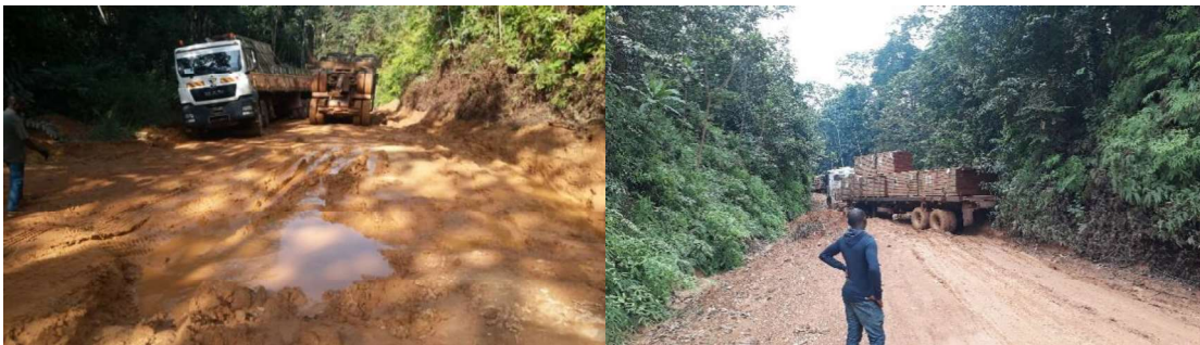
Figure 156 : Mauvais état de la route en saison des pluies
