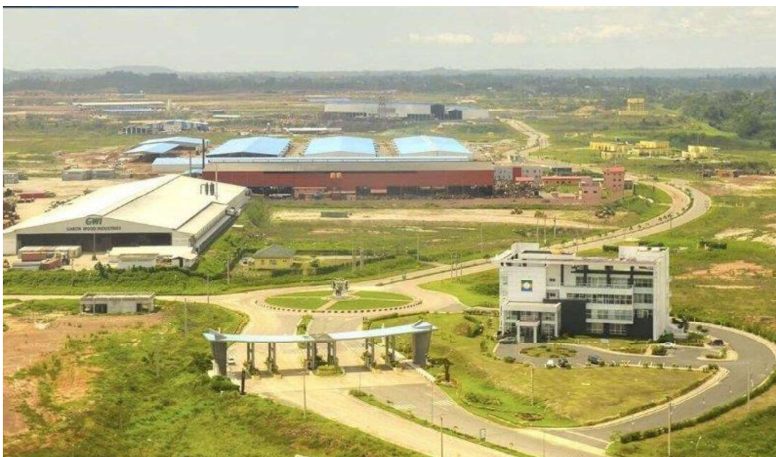
Figure 160 : Zone Economique Spéciale de Nkok située au Pk 24 du tronçon
