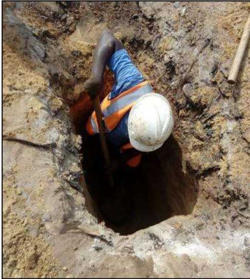
Image 5: Réalisation de puits de sondage sur le site (source : LABTP 2019)
