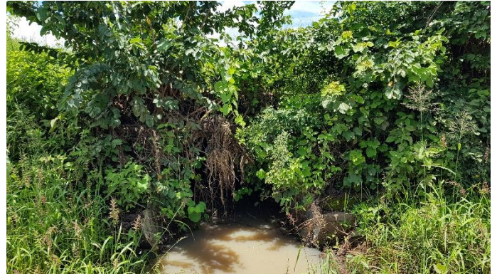
Culvert 2: 673160.26 m E , 8402829.22 m S
