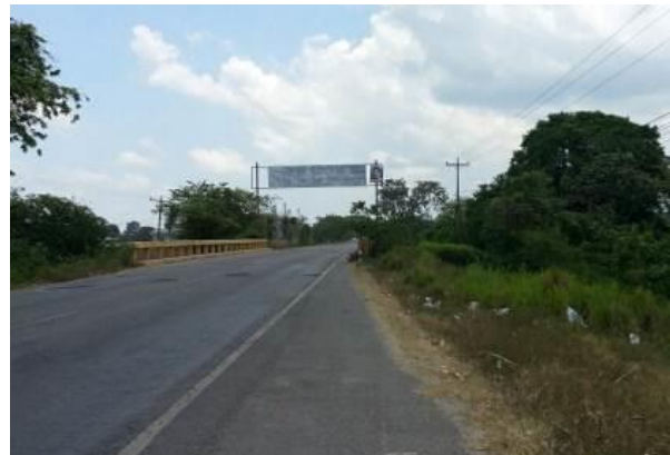
Puente en la Qda. Camalote
