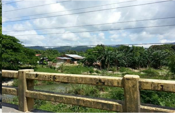
Puente sobre el Río La Esperanza
