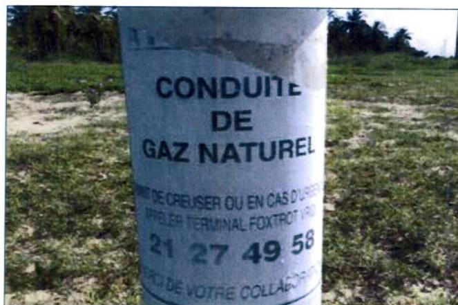
**Figure 11 : borne de signalisation du passage du gazoduc**
