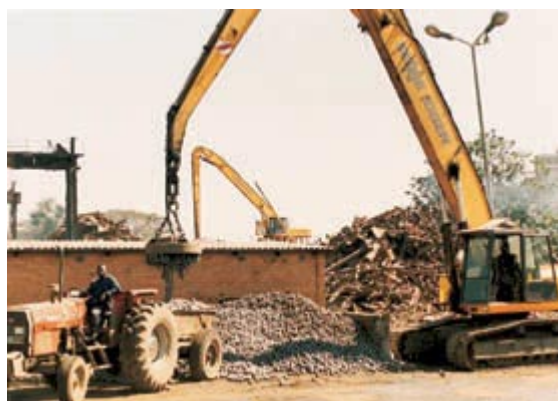
La garantie de MIGA a été d'une importance cruciale pour faciliter un investissement de 2 millions de dollars dans une fonderie qui est l'une des plus grandes d'Afrique centrale et la seule à produire des boulets d'acier en Zambie.
